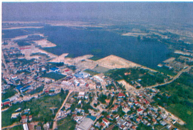
Remblaiement du boeung Poug Piey, nord-ouest de Toul Kok
