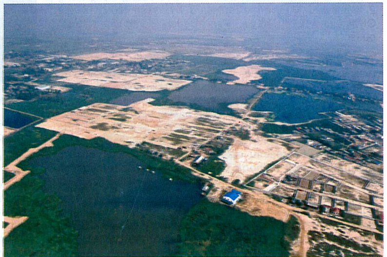
Remblaiement du boeng Prayap à l'ouest de Toul Kork
