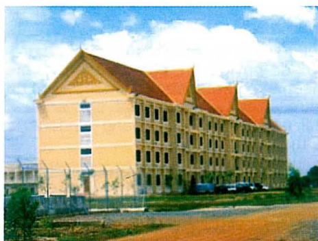
À 16 km de Phnom Penh sur la RN4 le bâtiment du quartier général des forces armées où le procès des khmers rouges aura lieu.
