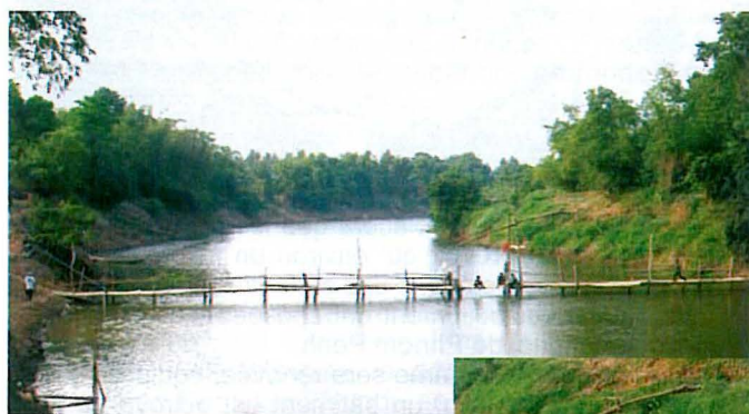
Un rare pont levant sur le Tonle Touit. Les inventeurs, constructeurs et managers de ce pont «à double péage» pour piétons et pour pirogues ne demandent que des droits modestes.
