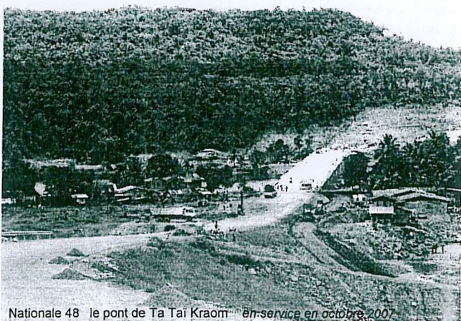
Nationale 48 le pont de Ta Tai Kraom en service en octobre 2007
