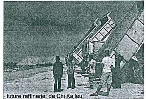
future raffinerie de Chi Ka leu
