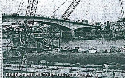
doublement en cours du pont Monivong
