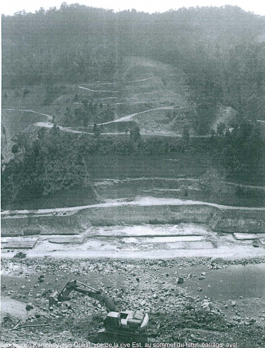
barrage de Kamchay, rive Ouest, vue de la rive Est, au sommet du futur barrage aval.
