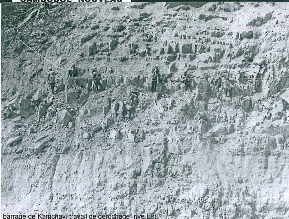
barrage de Kamchay, travail de dérochage, rive Est
