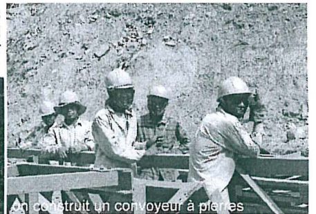
On construit un convoyeur à pierres
