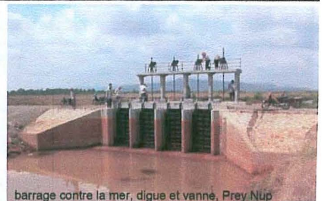
barrage contre la mer, digue et vanné, Prey Nup
