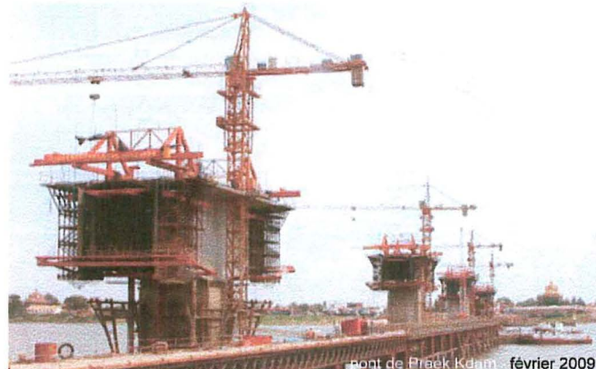
pont de Preaek Kdam - février 2009
