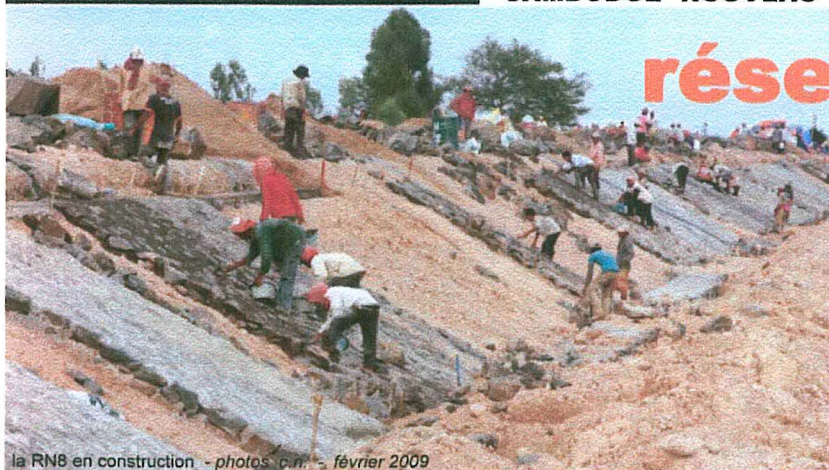
la RN8 en construction - photos p.n. - février 2009
