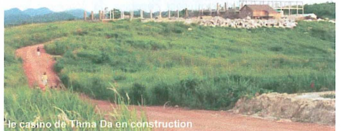
le casino de Thma Da en construction
