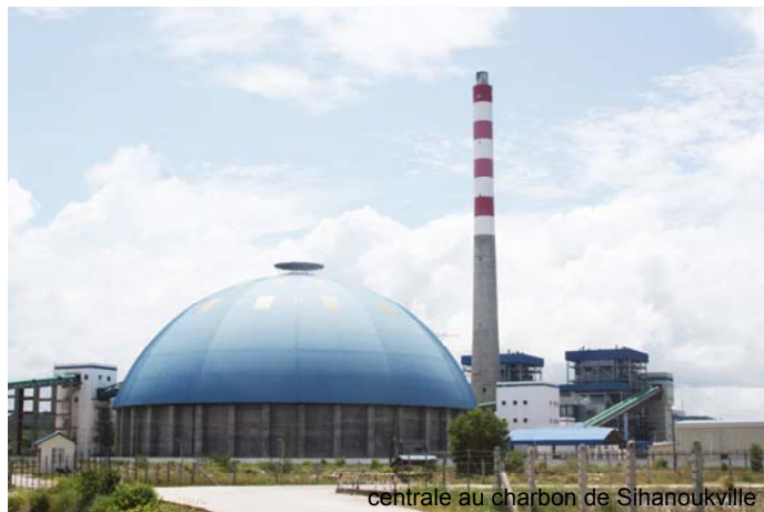
centrale au charbon de Sihanoukville
