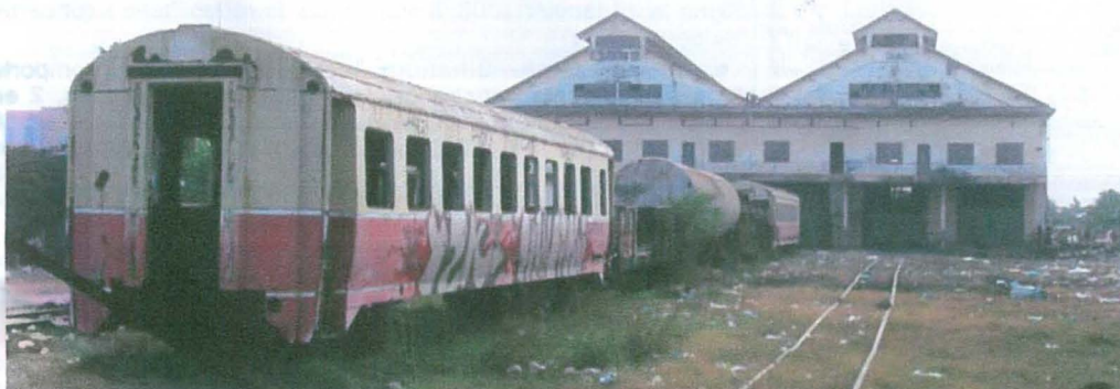
Ces hangars d'entretien du matériel roulant, entre le bd. Confédération de Russie et le boeung Kak, seront démantés à Samraong où se situera un centre d'échanges multi-modal, rail, route (RN5, RN4, et RN6 par le nouveau pont de Preah Kdam), port sec, à proximité de l'aéroport de Pochentong et de la PPSEZ. Les terrains qui sont la propriété des chemins de fer (notamment les gares et terrains environnants) peuvent contribuer à rentabiliser le réseau (marchés, boutiques ...).
