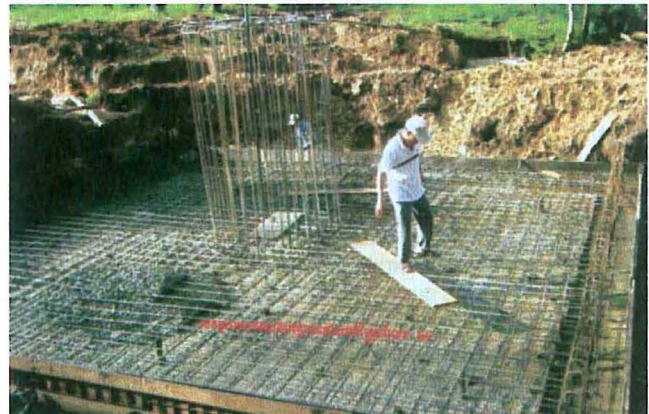
Travaux de préparation du fondement de la borne frontière n° 44 dans la province de Mondolkiri- Daklac
